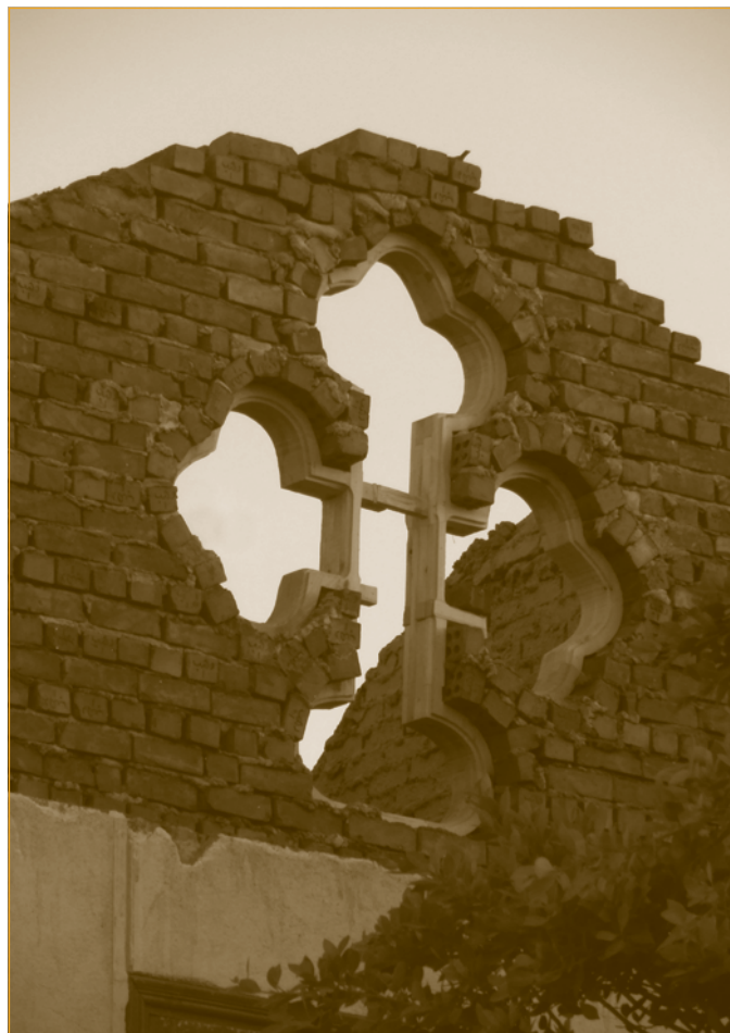
Detail ze stavby nového kláštera sv. Simeona nedaleko Asuánu
